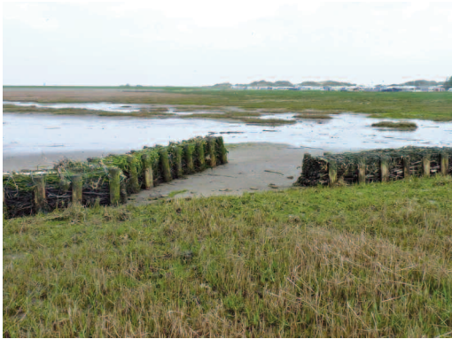
Abb. 8: Lahnung mit Öffnung. Foto: Hartmut Andretzke. – Breakwater with opening.
