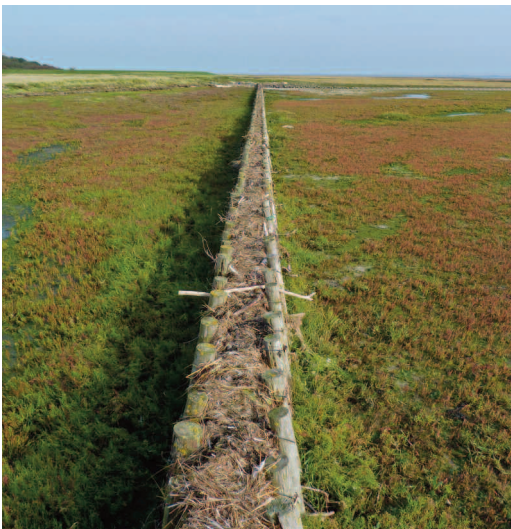
Abb. 3: Buschlahnung in der Bucht „Um Ost“. Foto: Hartmut Andretzke. – Breakwater in the bay „Um Ost“.
